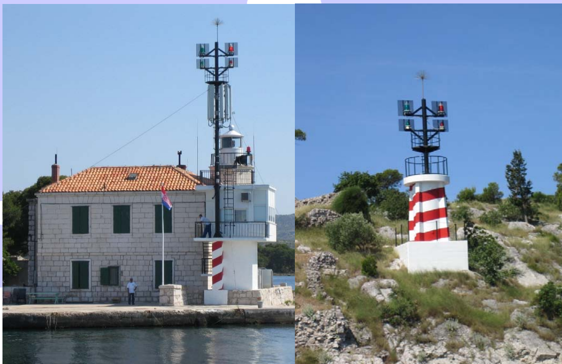
Slika 4: Sustav za nadzor i upravljanje plovidbom kanalom Sv. Ante (Semaforska svjetla na signalnim postajama Jadrija i Martinska)
