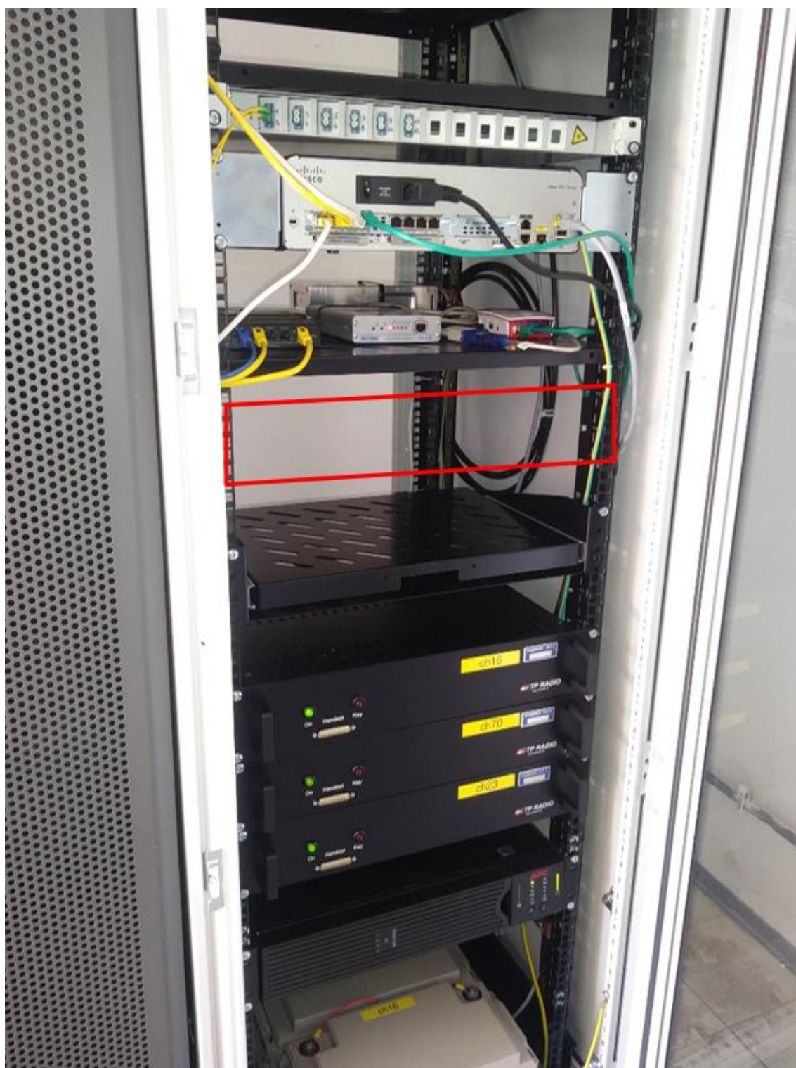
Slika 2.3-6 Pozicija bazne stanice u komunikacijskom ormaru
