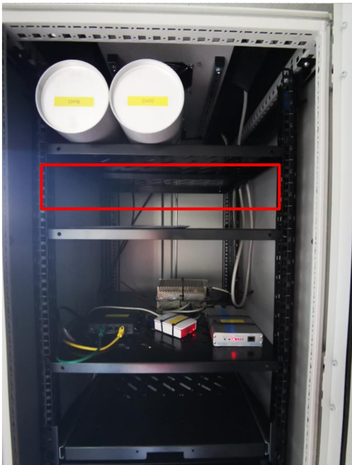
Slika 2.10-5 Pozicija bazne stanice u komunikacijskom ormaru
