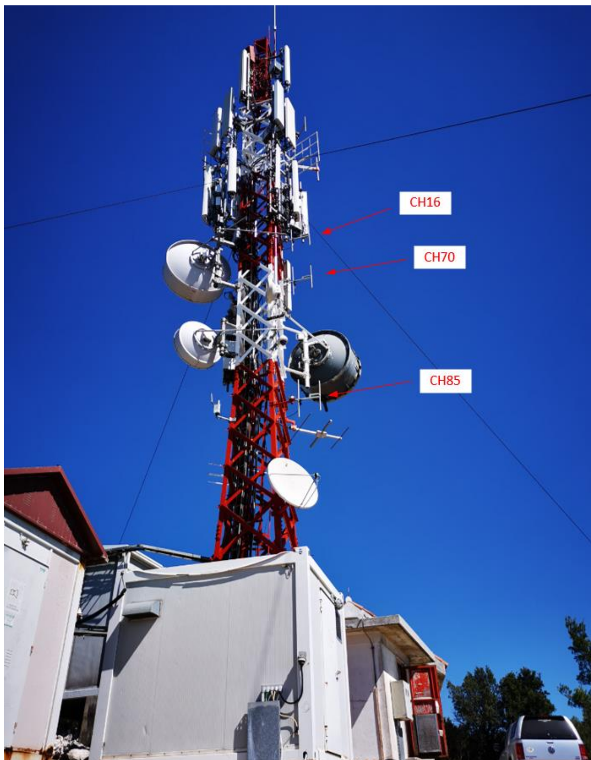
Slika 2.9-1 Položaj antena u vlasništvu Naručitelja na stupu
