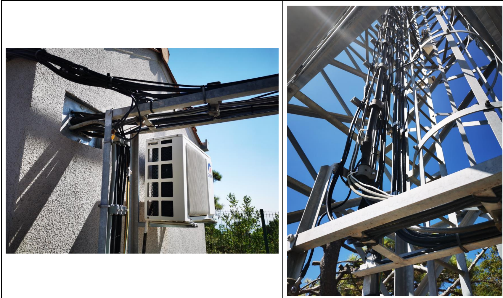
Slika 2.8-6 Prikaz trase kabela
