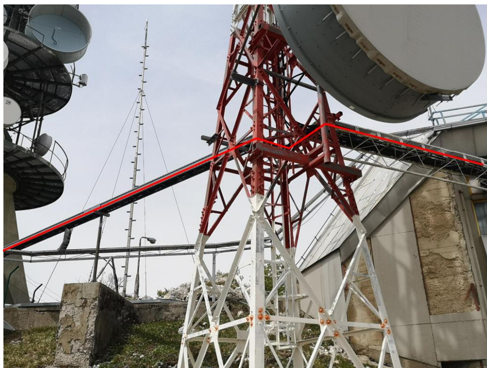
Slika 2.1-3 Prikaz trase kabela do ulaska u objekt
