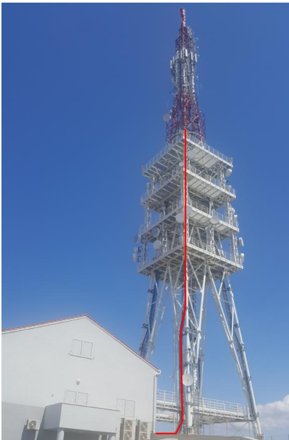
Slika 2.5-2 Prikaz trase kabela
