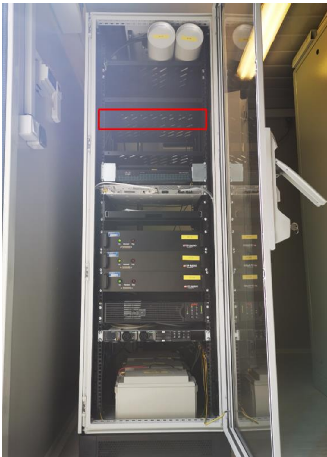
Slika 2.4-7 Pozicija bazne stanice u komunikacijskom ormaru
