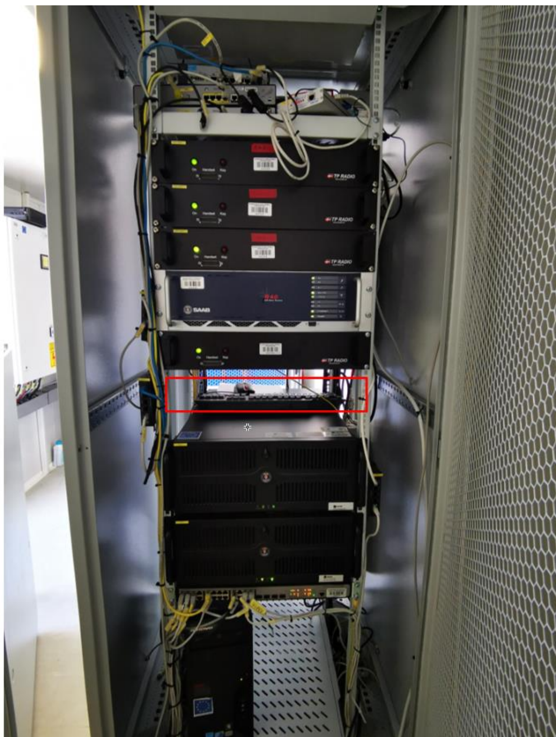
Slika 2.6-6 Pozicija bazne stanice u komunikacijskom ormaru
