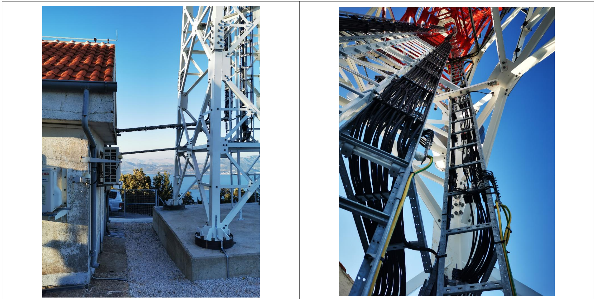
Slika 2.10-4 Prikaz trase kabela
