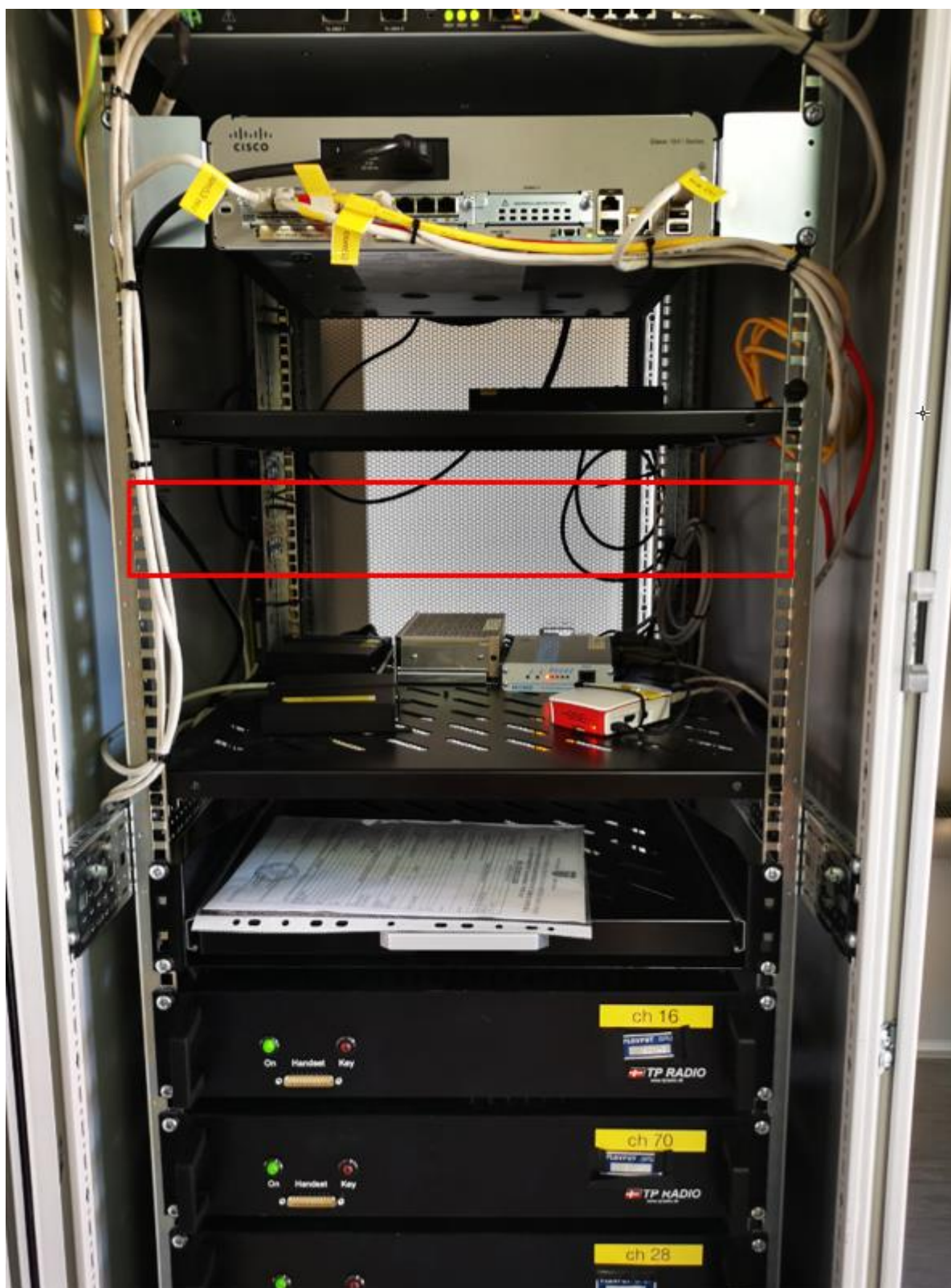
Slika 2.8-7 Pozicija bazne stanice u komunikacijskom ormaru
