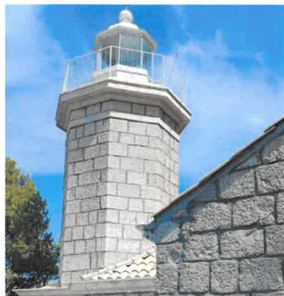
Slika 3. Pomorski svjetionik Daksa - nakon sanacije
