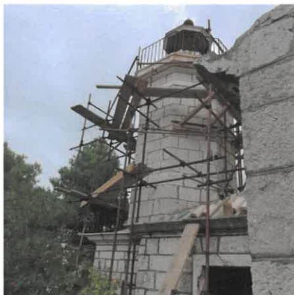
Slika 2. Pomorski svjetionik Daksa – radovi sanacije
